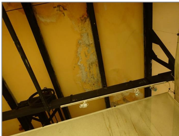
Feuchteschäden – Dachbereich
