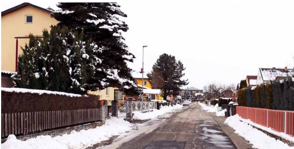
Unter anderem wird es in der Nestroygasse Straßensanierungen geben.
