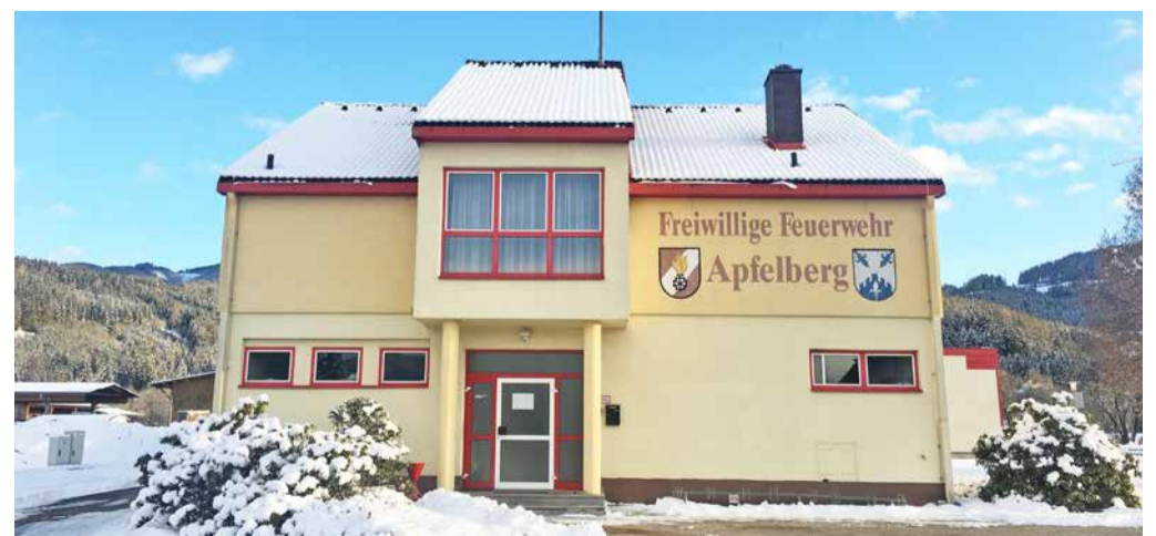
Das Gebäude der Freiwilligen Feuerwehr Apfelberg.
